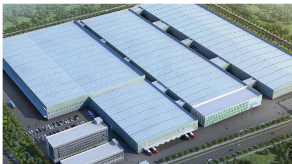
Завод электронных подвесок SENSEN, Чучжоу (Завод III)
